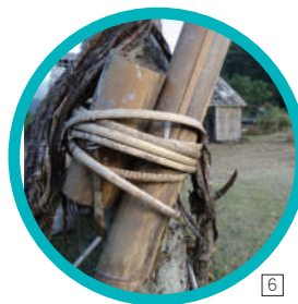
1.砍下的竹子放置在傳統石板屋旁。 2.頭目家牆上的舊照片。 3.用黃藤捆綁竹子是一種傳統工法。
